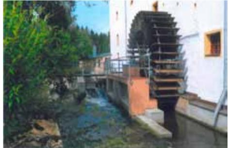
Die Brodmühle ist eine voll funktionsfähige Kunstmühle zum Vermahlen von Getreide. Sie besitzt ein unterschlächtiges Wasserrad, zwei doppelte und einen einfachen Walzenstuhl, einen Plansichter. Die Technik stammt aus dem 20. Jahrhundert.
